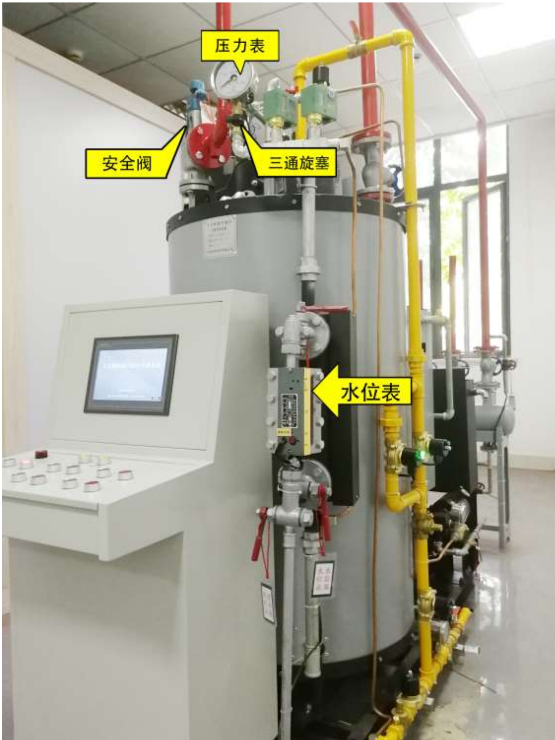
燃气、油锅炉实际操作考核设备示意（部件识别）图
